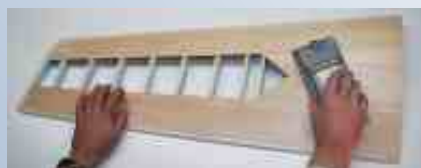
Fig. 2 Lijar uniformemente las superficies
