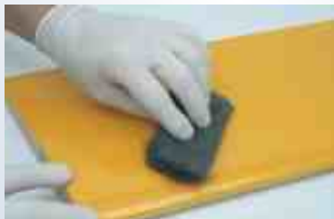
Aguce ORACOVER ® con un estropajo de acero de grado "000".
